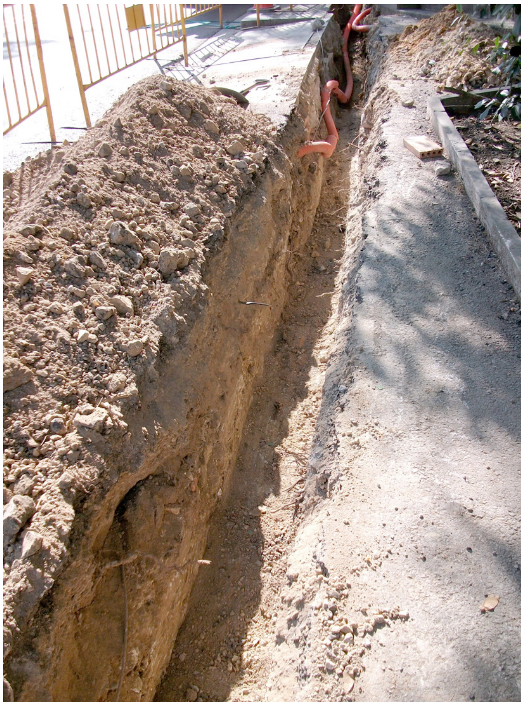
Vista del tram final de la rasa.
